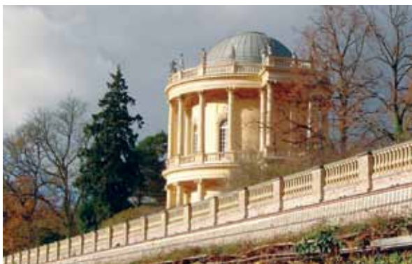
Talutmauern auf dem Klausberg Foto: SPSPG
