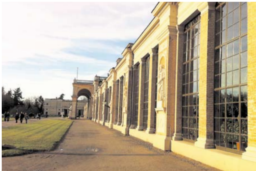
Blick entlang der Südfassade der östlichen Pflanzenhalle
