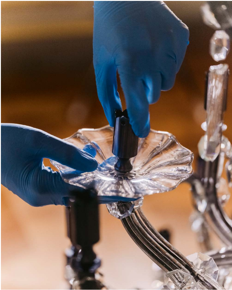
Ein Detail des Maria-Theresia-Kronleuchters: ein original erhaltener Tropfteller, auf den eine rekonstruierte Kerzentülle gedreht wird.
