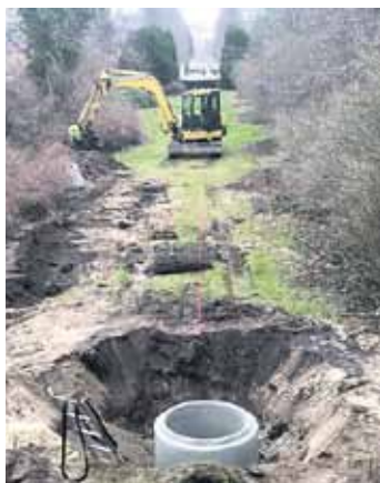
Baustelle für ein Regenwasserrückhaltesystem, 2021. Foto: Hans-Georg Bröker
