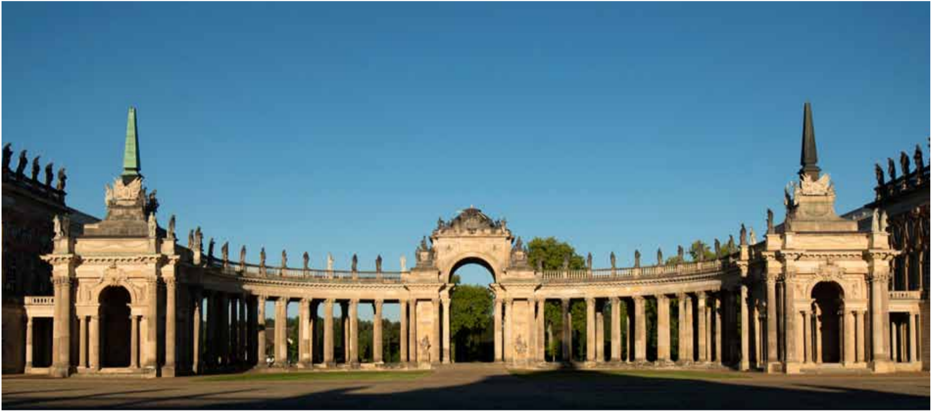
Kolonnade am Neuen Palais mit neuer Kuppel über dem Triumphtor; nach Abschluss der Sanierung, 2015. Foto: Leo Seidel
