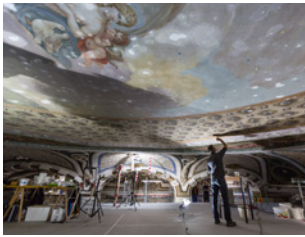
Neues Palais, Restaurierungsarbeiten im Grottensaal Foto: Franca Wohlt
