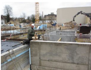
Künftiges WRZ, Kellerbau Foto: Demir Arslantepe
