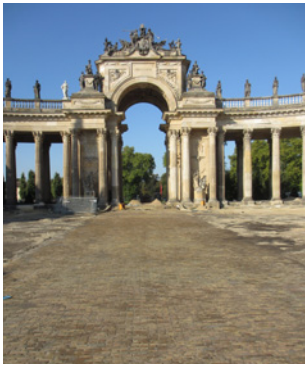
Fertiggestelltes Triumphthor mit freigelegter Mopke Foto: Frank Aulbach
