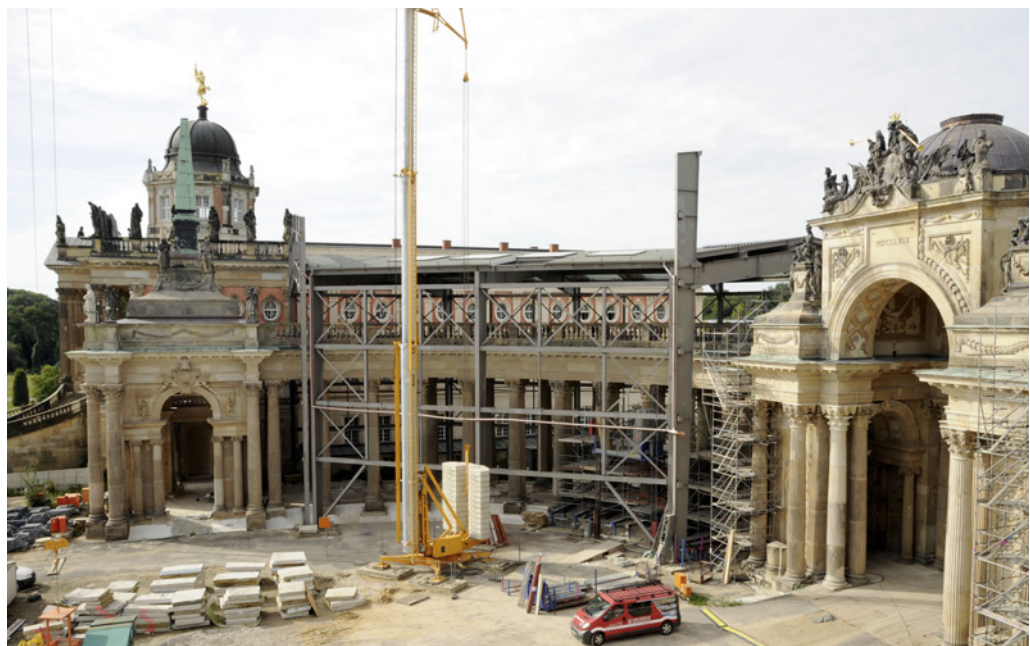
Abrüstung der Kolonnade: Südflügel und Triumphthor im September 2012 Foto: Frank Aulbach
