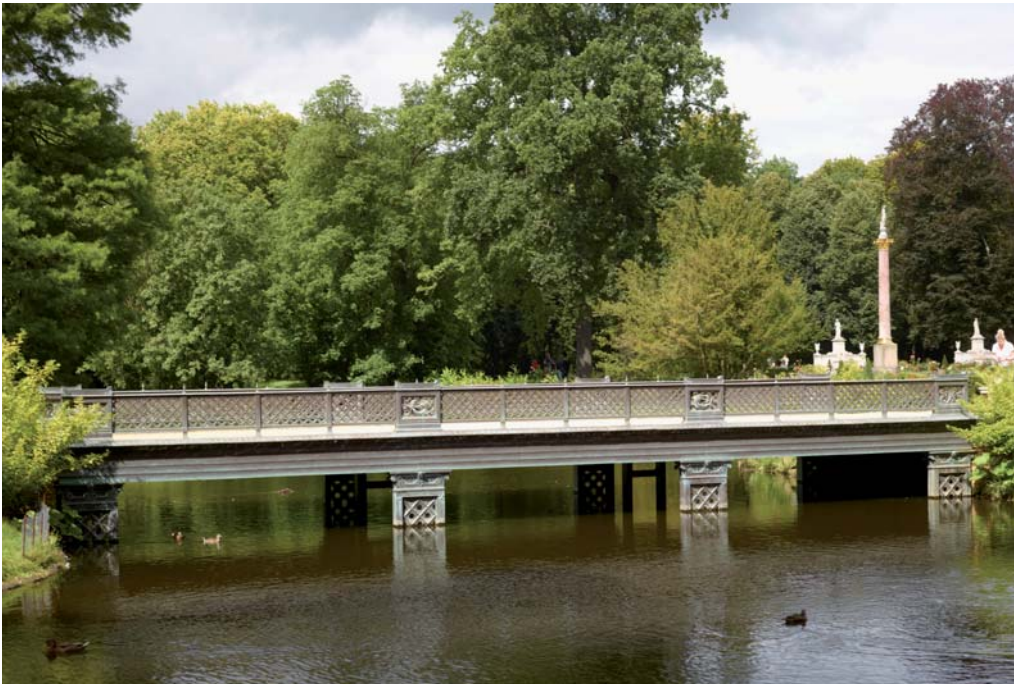
Blick auf die restaurierte Tritonenbrücke Foto: Wolfgang Pfau
