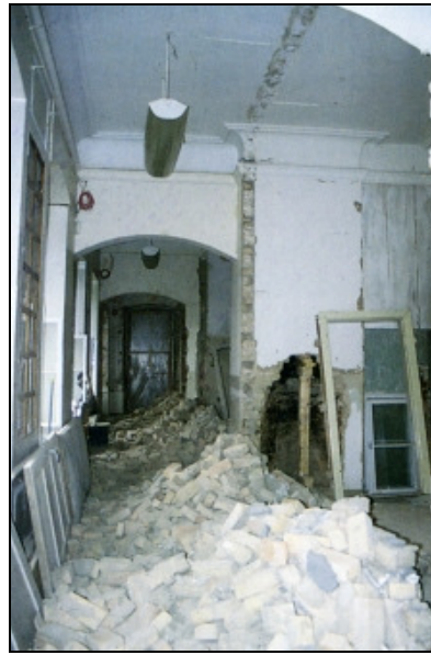
Rheinsberg, Schloss, Blick in die Sommerwohnung des Prinzen Heinrich Zustand während des Beginns von umfangreichen Rückbaumaßnahmen. Foto: SPSG, Detlef Fuchs, Februar 2000
