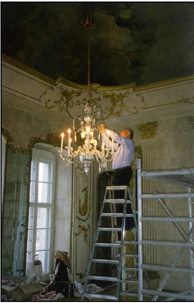
Rheinsberg, Schloss, Spiegelsaal Aufhängung der rekonstruierten Kronleuchter. Foto: SPSG, Detlef Fuchs, November 1999
