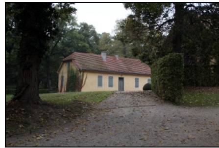
Rheinsberg, Schlosspark, Hofgärtnerhaus nach der Instandsetzung, 2015 Foto: SPSG, Detlef Fuchs
