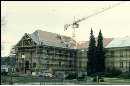
Rheinsberg, Schlosspark, Kavalierhaus, Schlosstheater, Ansicht von Südosten Zustand während der Einrüstung und Rekonstruktion des Dachstuhles. Foto: SPSG, Detlef Fuchs, Februar 1999
