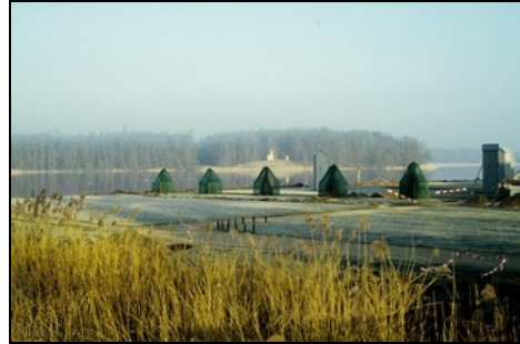
Rheinsberg, Schlossinsel, während der Baumaßnahmen Foto: SPSG, 1997
