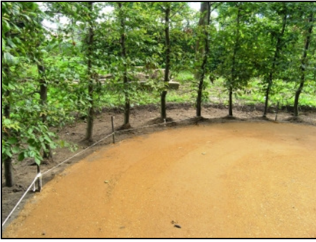
Rheinsberg, Schlosspark, Sternboskett, Aufbringen der Deckschicht Foto: SPSG, Katrin Schröder, 2005
