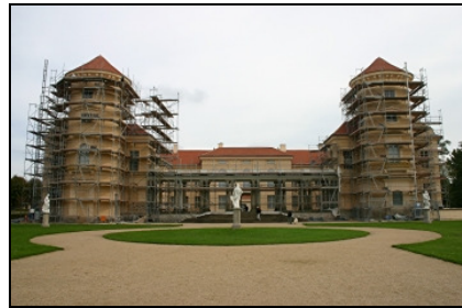
Rheinsberg, Schloss, Seeseite, kurz vor Vollendung der Fassadeninstandsetzung Foto: SPSG, Detlef Fuchs, 2007
