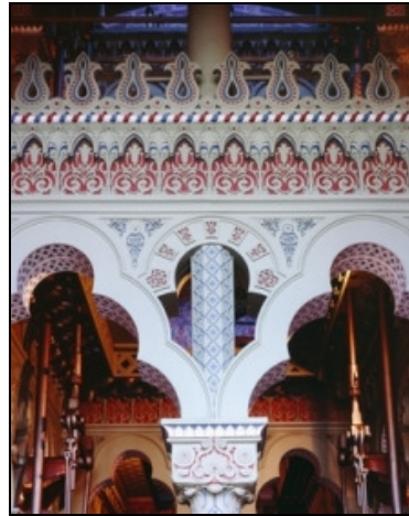
Potsdam, Dampfmaschinenhaus (Moschee) Maschinenraum, Detail der Arkaden Foto: SPSG, Michael Lüder, 2005
