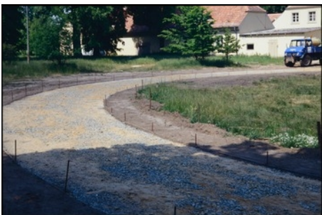
Potsdam-Sacrow, Park Sacrow, Wegebau Schlossrondell, Unterbau und eingeschlammter Sand Foto: SPSG, Michael Seiler, 1995
