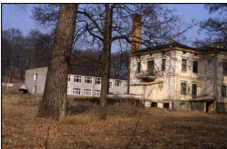
Potsdam, Pfingstberg, unterer Teil mit der Villa Quandt Vor den gärtnerischen Wiederherstellungsarbeiten mussten mehrere militärische Zweckbauten beseitigt werden. Auf der Abbildung sind im Hintergrund noch der Heizungsschornstein und der Plattenbau für die Unteroffiziere zu sehen.
