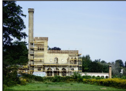
Potsdam, Neuer Garten, Meierei während der Restaurierung Foto: SPSG, Wolfgang Pfauder, 2002
