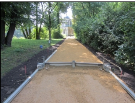
Potsdam, Neuer Garten, Weginstandsetzung an der Gotischen Bibliothek Foto: SPSG, Sven Kerschek, 2014
