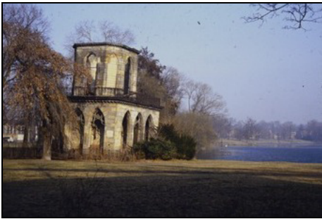
Potsdam, Neuer Garten, Gotische Bibliothek, vor der Instandsetzung Foto: SPSG, Jörg Wacker, März 1991
