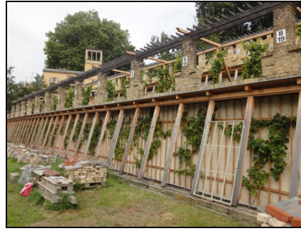
Potsdam, Winzerberg, Wiederherstellung der oberen Terrasse Foto: Roland Schulze, Baudenkmalpflege GmbH, 2015
