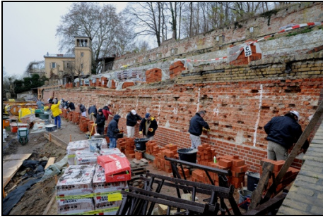
Potsdam, Winzerberg, Maurerarbeiten an den Terrassen Foto: Roland Schulze, Baudenkmalpflege GmbH, 2010
