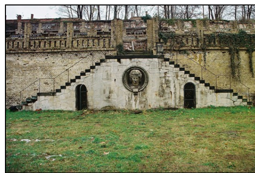
Potsdam, Winzerberg, Vorzustand der Bacchustreppe Foto: Roland Schulze, Baudenkmalpflege GmbH, 2007
