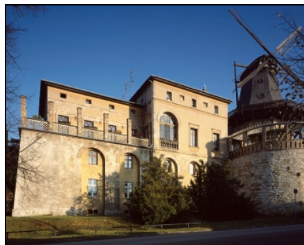
Potsdam, Park Sanssouci, Mühlenhaus an der Historischen Mühle Foto: SPSG, Hans Bach, 2004
