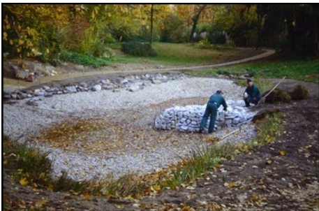
Potsdam, Park Sanssouci, Marlygarten, Restaurierungsarbeiten am Wasserlauf Foto: SPSPG, Jörg Wacker, 2000
