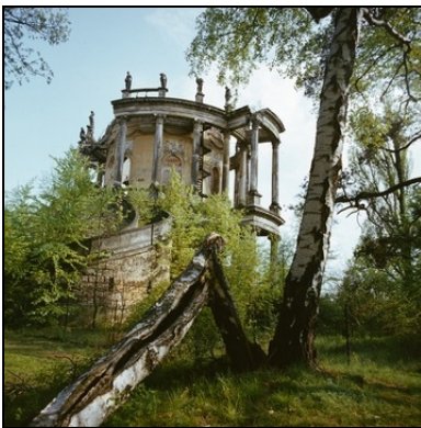
Potsdam, Park Sanssouci, Belvedere auf dem Klausberg, Ansicht der Nordseite vor der Restaurierung Foto: SPSG, Roland Handrick, 1990
