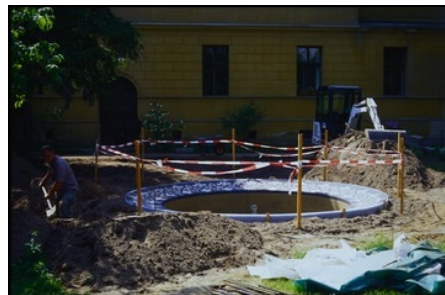
Potsdam, Park Sanssouci, Marlygarten, Restaurierungsarbeiten an der Mosaikfontäne Foto: SPSPG, Jörg Wacker, 2002
