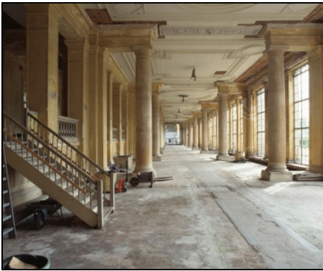
Potsdam, Park Sanssouci, Orangerie, Westliche Pflanzenhalle, Zustand vor dem Beginn der Dachsanierung Foto: SPSG, Roland Handrick, 1996
