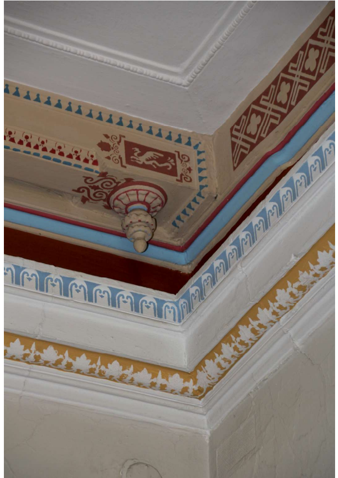
Kassettendecke mit Rahmenfüllungskonstruktionen, Zierbalken, Hängezapfen.
