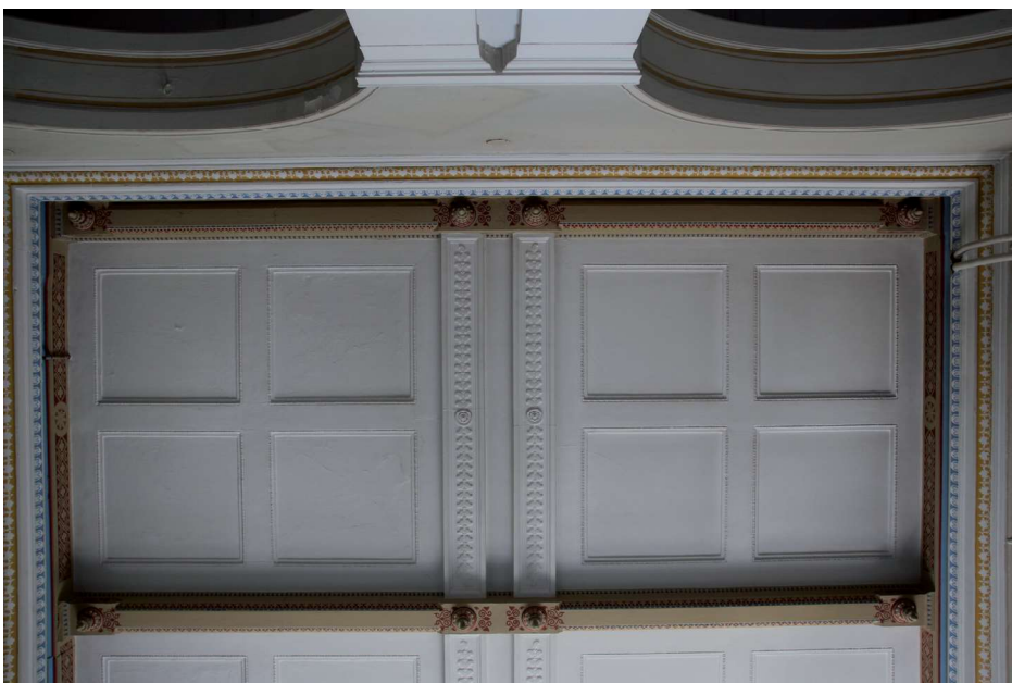
Kassettendecke mit Rahmenfüllungskonstruktionen, Zierbalken, Hängezapfen.
