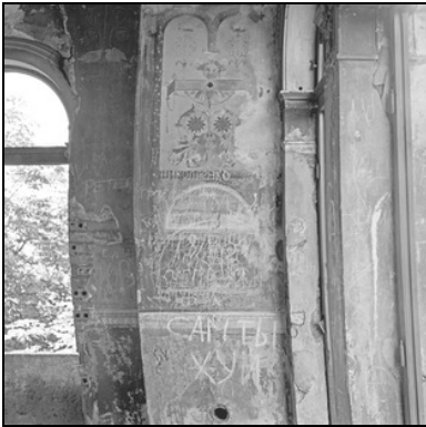
Potsdam, Pfingstberg, Belvedere, Römisches Kabinett, Wand- und Deckenmalerei Foto: SPSG
