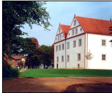
Königs Wusterhausen, Schloss, Ansicht von Süden Das gesamte Gebäude wies im Äußeren und Inneren starke Risse im Mauerwerk auf, die auf eine unzureichende Fundamentstabilität hinwiesen. Bei Instandsetzungsmaßnahmen 1966 bis 1968 erhielten die Fassaden einen kompletten Neuverputz. Dieser Kalkzementputz hatte eine Stärke von bis zu 12 cm und verunklärte das ursprüngliche Erscheinungsbild. Foto: SPSG, 1997
