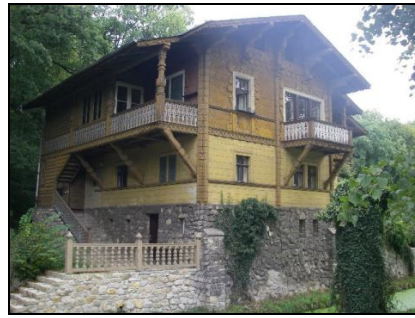
Potsdam, Klein Glienicke, Schweizerhaus, Louis-Nathan-Allee 6 mit wiederhergestellter Treppenanlage Foto: LHP 2014
