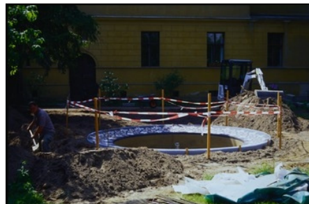
Potsdam, Park Sanssouci, Marlygarten, Restaurierungsarbeiten an der Mosaikfontäne Foto: SPSSG, Jörg Wacker, 2002
