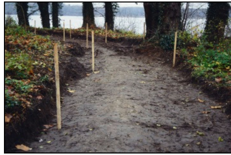
Caputh, Schlosspark, Absteckung während der Arbeit an einem Parkweg Nachdem durch Suchgrabung an einigen Stellen der historische Wegeverlauf ermittelt werden konnte, dient die Absteckung der Findung der gartengestalterisch harmonischen Verbindungslinie dieser Partien Foto: SPSG, Gerd Schurig, November 1996
