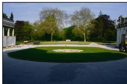
Potsdam, Neuer Garten, Marmorpalais, wiederhergestellter Ehrenhof, Ansicht von Osten Bei den Arbeiten konnten alte Begrenzungslinien und Anschlusshöhen gesichert werden. Danach wurde die Hofgliederung mit Brunnenbecken wieder angelegt. Foto: SPSG, Gerd Schurig, Mai 1997
