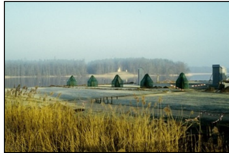
Rheinsberg, Schlossinsel, während der Baumaßnahmen Foto: SPSG, 1997
