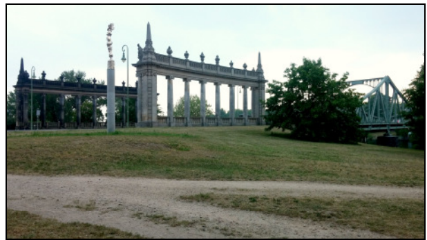
Potsdam, Glienicker Brücke nach der Sanierung Foto: LHP
