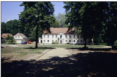
Potsdam-Sacrow, Schloss Sacrow, Ansicht von Süden mit Schlossrondell Nach jahrzehntelanger Fremdnutzung war das Schloss 1993 ohne gravierende Bauschäden zur SPSG gekommen. Unter einem Dach aus Betonsteinen und umgeben von Baracken und Betonwegen bot es allerdings ein tristes Bild. 1995 war die Wiederherstellung des Daches schon abgeschlossen und mit der Arbeit am Schlossrondell bereits begonnen worden. Foto: SPSG, Michal Seiler, 1995
