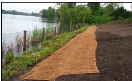
Potsdam, Neuer Garten, Ufersanierung Foto: SPSG, Eva Riks, 2005
