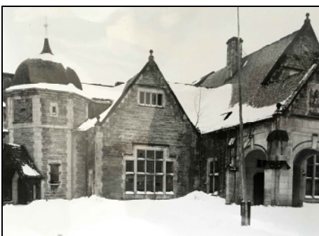
Potsdam, Kaiserbahnhof vor der Sanierung Foto: LHP
