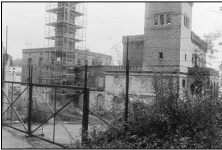
Potsdam, Park Babelsberg, Maschinenhaus Foto: SPSG, Peter Rohn
