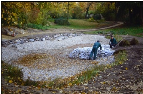
Potsdam, Park Sanssouci, Marlygarten, Restaurierungsarbeiten am Wasserlauf Foto: SPSSG, Jörg Wacker, 2000
