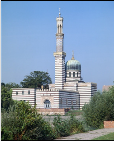
Potsdam, Dampfmaschinenhaus (Moschee) Blick von der Wasserseite Foto: SPSG, Gerhard Murza, 1992
