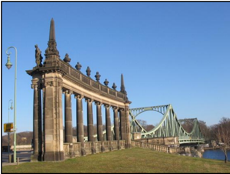
Potsdam, Glienicker Brücke vor der Sanierung Foto: LHP, Lienhard Schulz/GNU Free Documentation License
