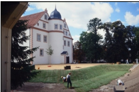
Königs Wusterhausen, Park Der angeedeutete Schlossgraben wird mit Rollrasen belegt. Foto: SPSG, Jörg Wacker, August 2000
