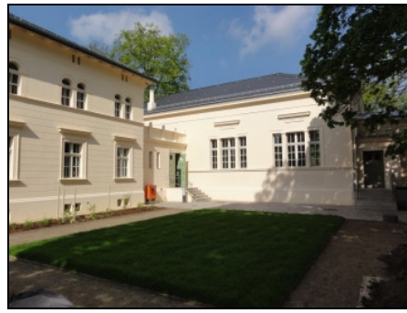
Potsdam, Schopenhauerstraße 24, Friedenssaal Foto: LHP, 2012
