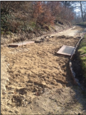
Potsdam, Park Babelsberg, Restaurierung Schluchtweg, Setzen der Schächte Foto: SPSG, Katrin Schröder, 2014
