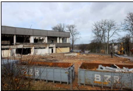
Potsdam, Park Babelsberg, Abriss Universitätsgebäude Foto: SPSG, Katrin Schröder, 2008
