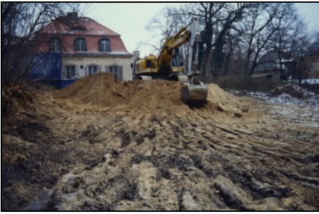
Caputh, Schlosspark, Obstwiesenbereich westlich vom Anbau während der Kiesberäumung Hier mussten im Dezember 1995 fast 2000 m 3 Kiesanschüttung beräumt werden, die vom Vornutzer des Areals zum Bau eines Gebäudes angeschüttet worden waren Foto: SPSG, Gerd Schurig, Dezember 1995
