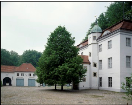
Berlin, Jagdschloss Grunewald, Ansicht von Südost nach der 1991 erfolgten umfassenden baulichen Instandsetzung außen und innen Foto: SPSG, Jörg P. Anders, 1970–2004
